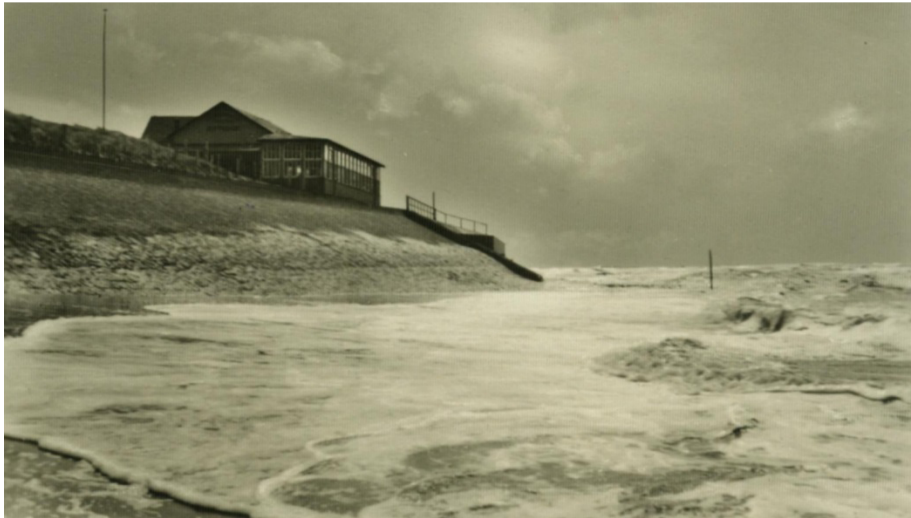
Bild 16 Die Strandhalle auf der Brandungsmauer am Westend
