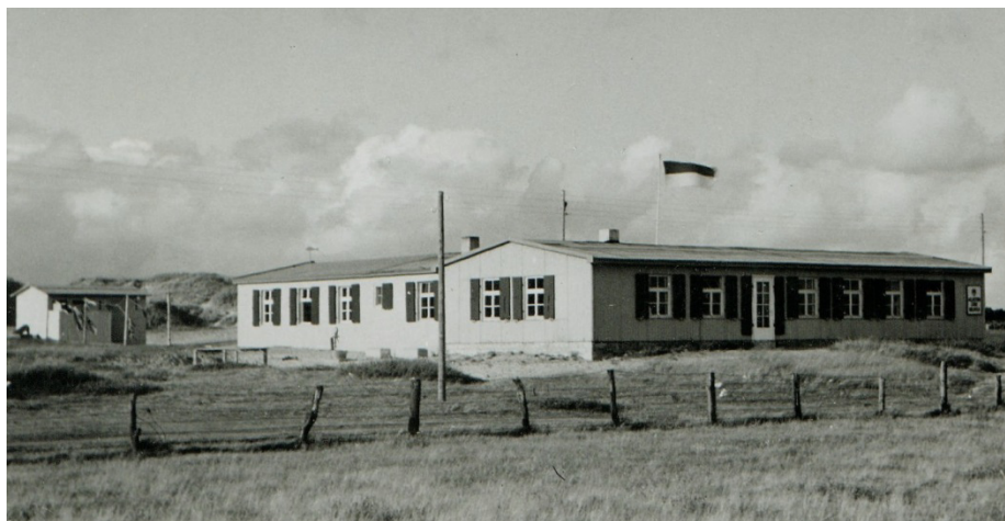
Bild 4 Das Landheim von der Wattseite, 1950
